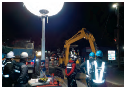
花山交差点の漏水復旧工事現場
