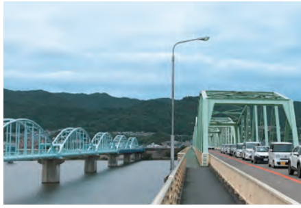
復旧した六十谷水管橋と県道六十谷橋
