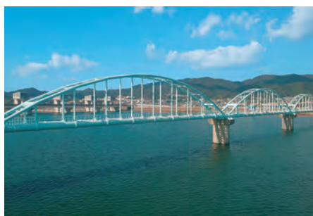
六十谷水管橋
