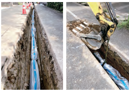
水道管の更新工事
