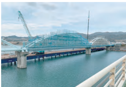
復旧工事中の六十谷水管橋
