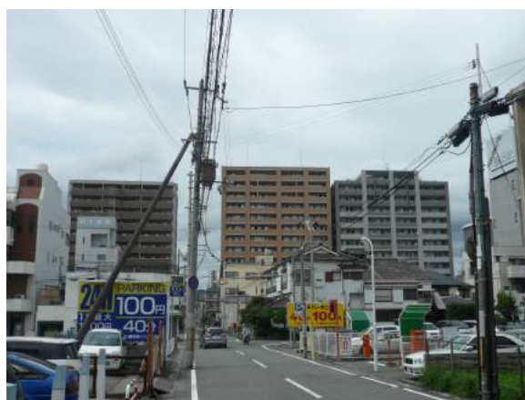
JR 和歌山駅近くに立地するマンション
