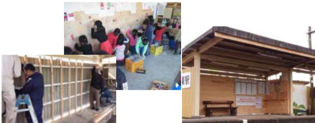
山東地域におけるまちづくりの取り組み（住民による山東駅の改修：左・中・作業中、右・完成）
