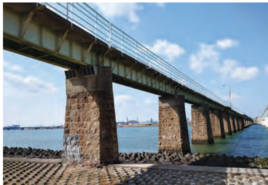
▲鉄道橋を転用して使用されてきた旧河西橋
