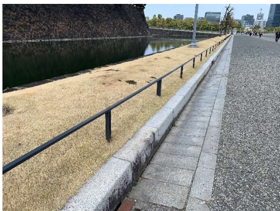
図4-11 芝生エリアとの境界に設置する柵のイメージ（皇居付近）
