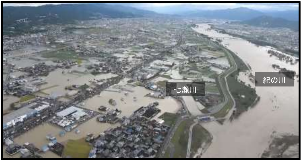
平成 29 年 台風 21 号による被害
