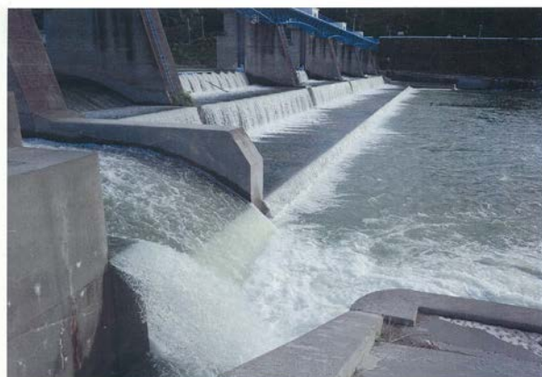
下流「大迫力の頭首工」
