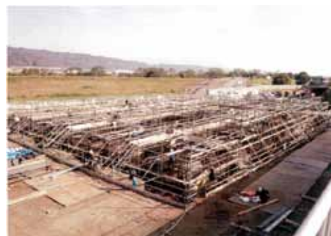
更新中の加納浄水場
