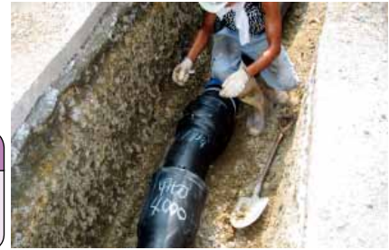
管の布設替工事
