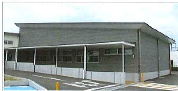
和歌山市民図書館西分館
