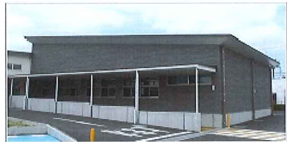
和歌山市民図書館西分館
