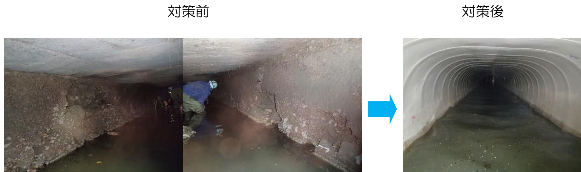
図48 長寿命化による対策実施例（管渠更生工法）
