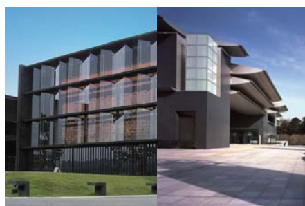
和歌山らしさを考慮した建築事例
