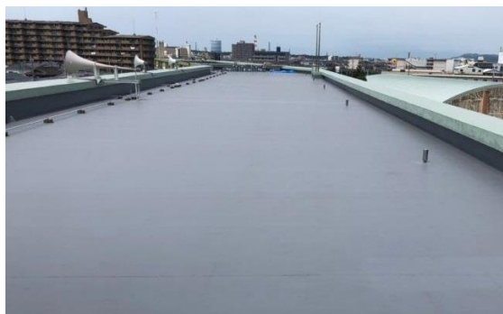
<予防改修事業(屋上防水・外壁改修)>
