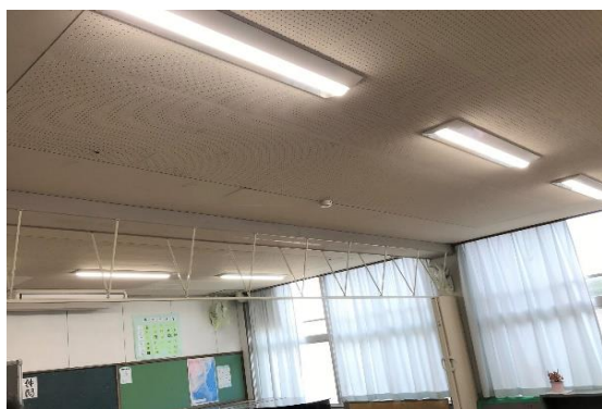
<LED照明設置事業>
