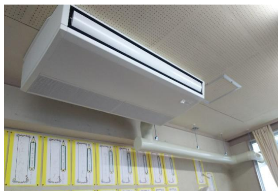
<空調改修事業>
