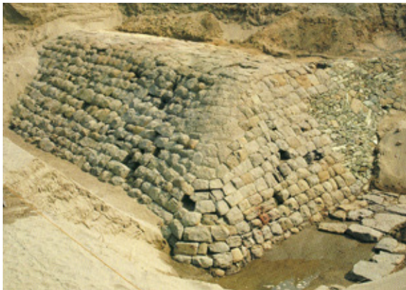
4-8 水軒堤防(堤防の石積み)
