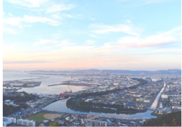
4-8 水軒堤防と西浜遠景
