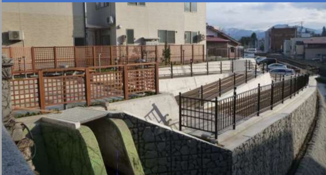
写真 1：かわまちづくり支援制度に基づき整備された青森県弘前市・土淵川沿いの橋詰広場
