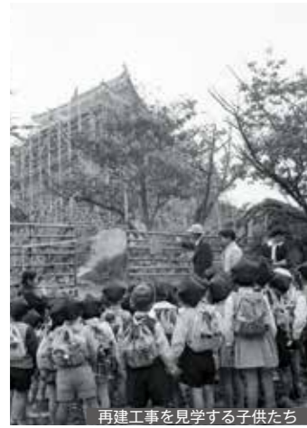
再建工事を見学する子供たち
