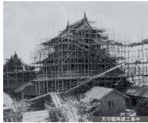
天守閣再建工事中
