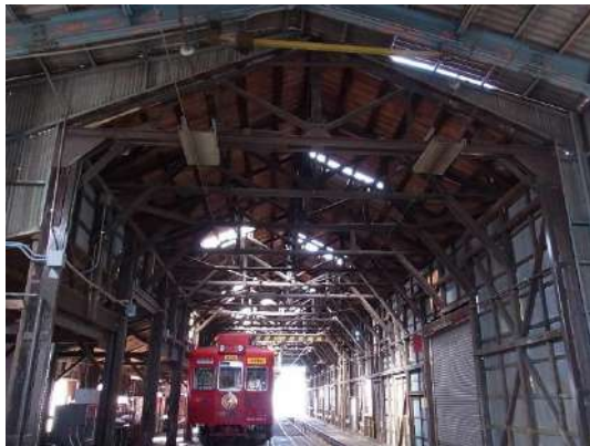
和歌山電鐵貴志川線伊太祁曽駅検査場
