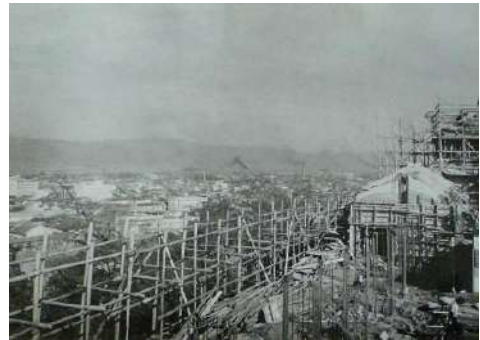
天守閣再建工事 (昭和31年(1956)～昭和32年(1957)頃)
