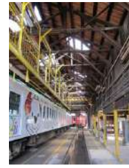
和歌山電鐵貴志川線 伊太祁曽駅検査場
