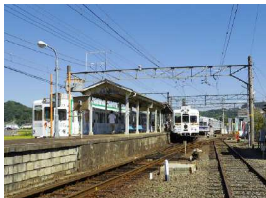
和歌山電鐵貴志川線伊太祁曽駅 プラットフォーム及び上屋
