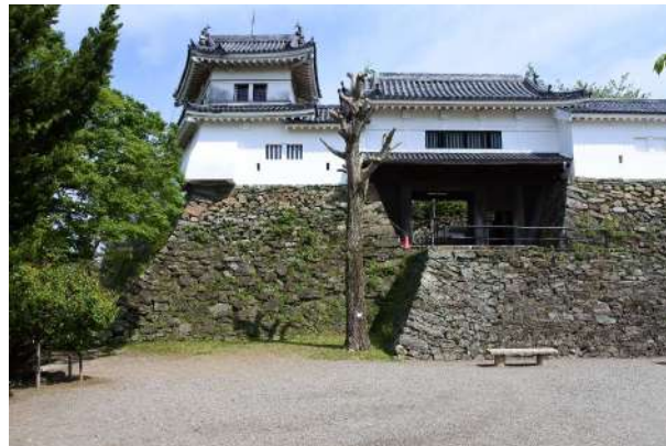
青石を使用した和歌山城の石垣
