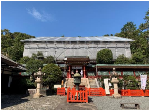
東照宮本殿等修復 仮設覆屋
