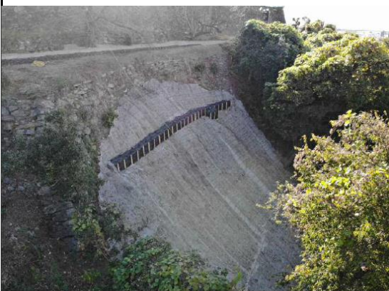
復旧工事が完了した和歌山城天守曲輪北側斜面の崩落現場
