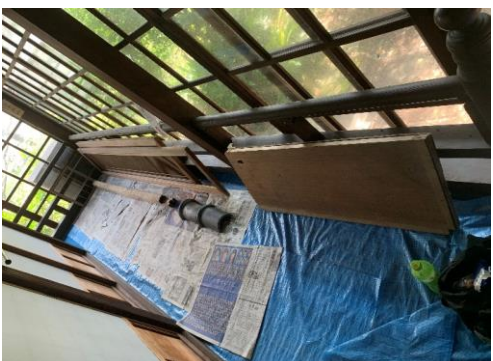
災害復旧事業 名勝和歌の浦(旧芦辺屋別館)修復
