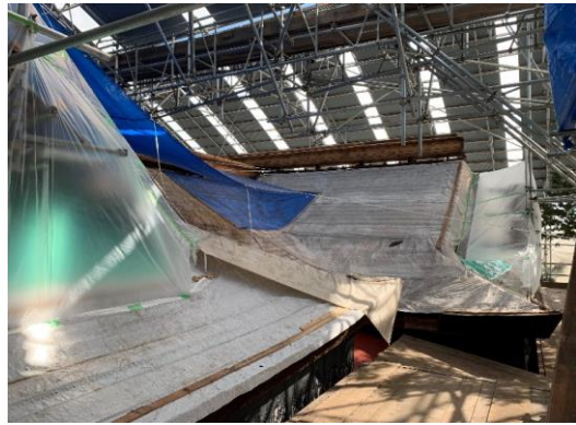
東照宮本殿等修復 屋根葺き替え
