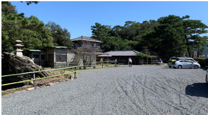
先行外構工事完了
