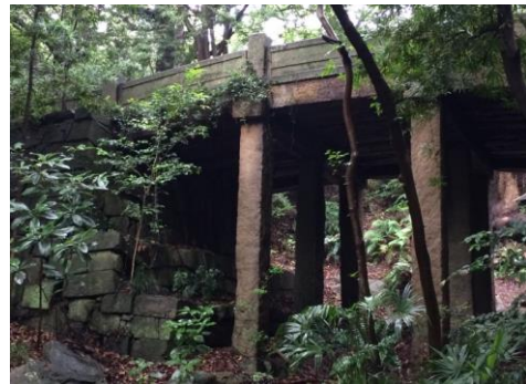
(整備予定)東照宮参道石橋
