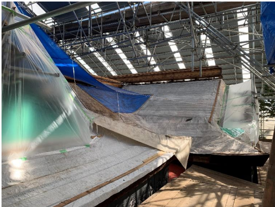
重要文化財東照宮本殿他修復事業 (屋根葺替え)
