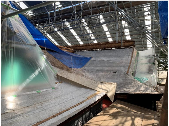
東照宮本殿等修復 屋根葺き替え
