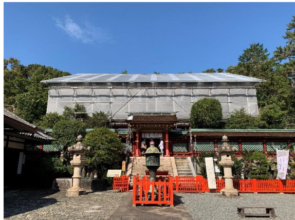
東照宮本殿等修復 仮設覆屋
