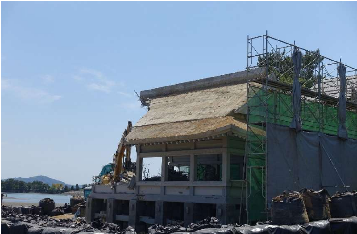
観海閣(解体中)
