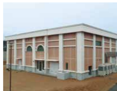
真砂配水場新設(平成31年度稼働予定)
