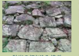
砂岩の打ち込み接ぎ
