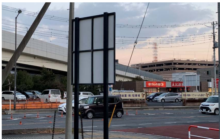
図 2-22 屋外広告物の裏側が見えている事例
