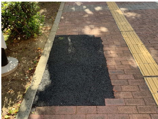
図 2-2 異なる舗装の種類で修繕している事例
