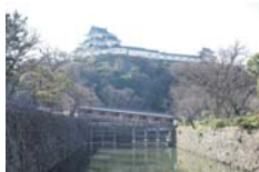
和歌山城、風致地区 寺町通り
