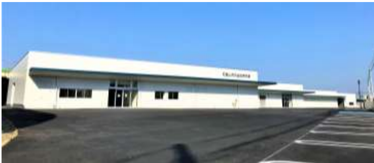
総合食品センター（全体）
