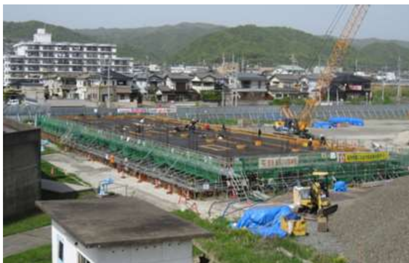
建設中の六十谷第2浄水場東側用地東送水ポンプ棟
