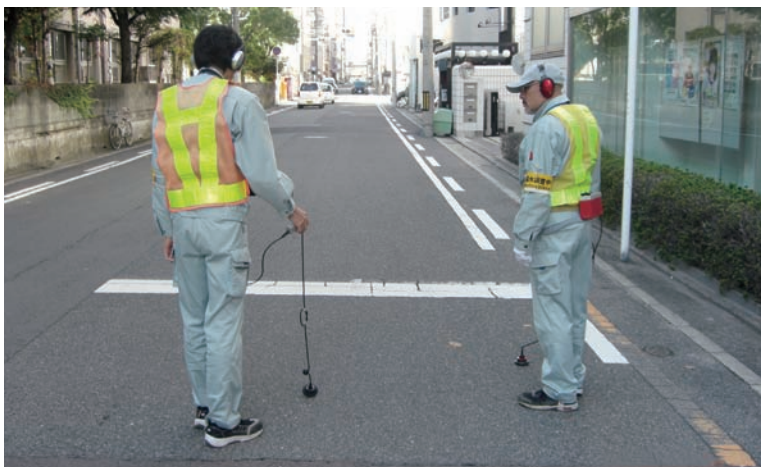
漏水探知機を使った音聴調査
