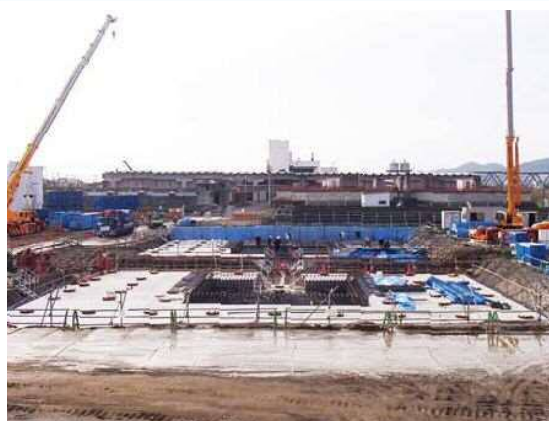
加納浄水場排水処理施設土木工事
