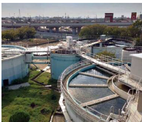
出島浄水場強沈改修工事
