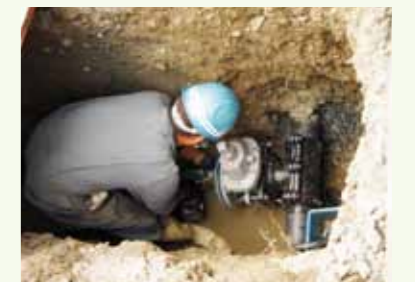
新規水道管の布設工事
