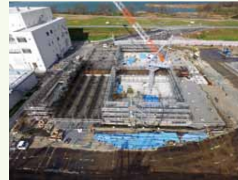
凝集沈澱池更新工事の現況
