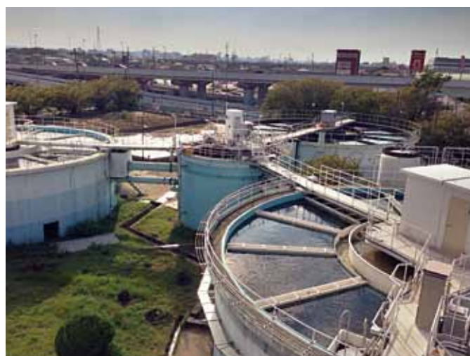
濁りを沈める沈澱池(出島浄水場)
