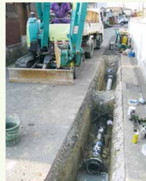
老朽水道管の布設替工事
