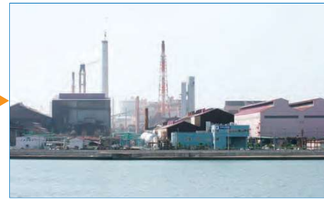
日本製鉄関西製鉄所和歌山地区
