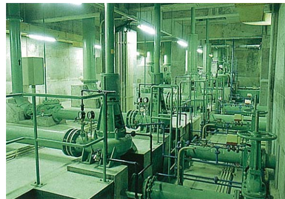
▲汚水ポンプ室
