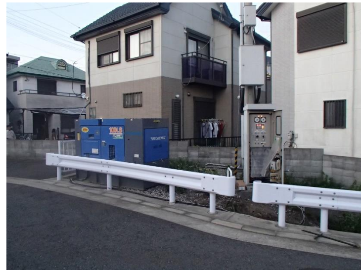
図 3-29 仮設電源の設置例（旭橋マンホールポンプ1号）
