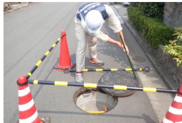
マンホール緊急点検措置状況
