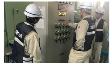
ポンプ場緊急点検調査状況
