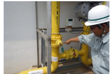
処理場緊急点検調査状況
