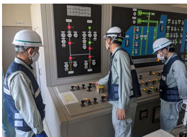
ポンプ場の機能復旧状況
