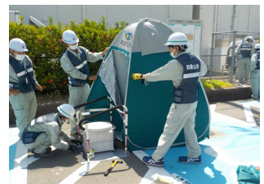
マンホールトイレ設置状況
