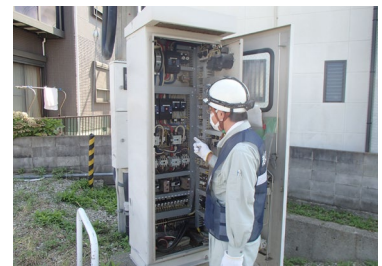
マンホールポンプの機能復旧状況
