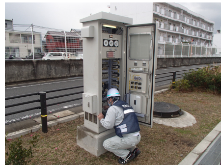
マンホールポンプ復旧作業状況
