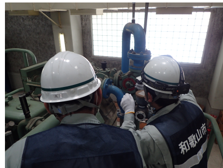
処理場雨水ポンプ復旧作業状況
