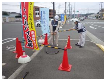
マンホール緊急点検措置状況
