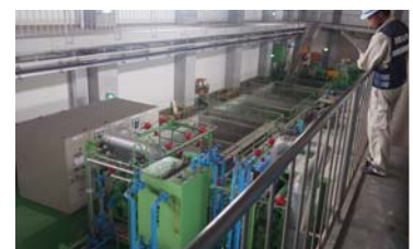
ポンプ場緊急点検調査状況
