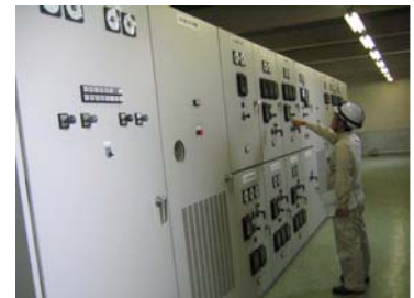
処理場緊急点検調査状況
