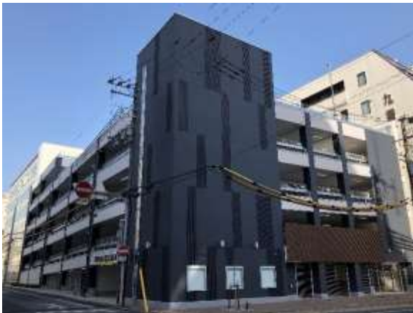
○市営北駐車場
