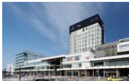
市街地再開発事業による再整備
