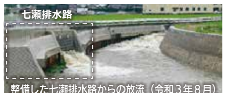
整備した七瀬排水路からの放流（令和 3 年 8 月）
