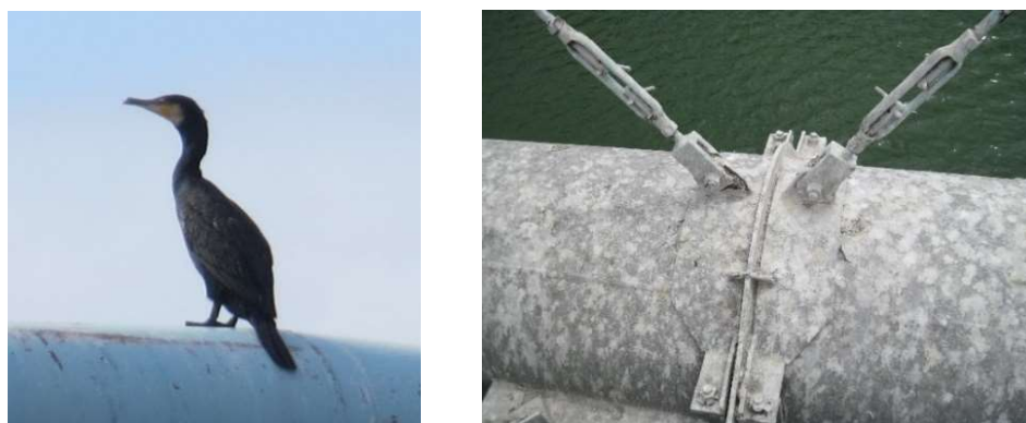
図-4 水管橋に留るカワウと糞の堆積状況
