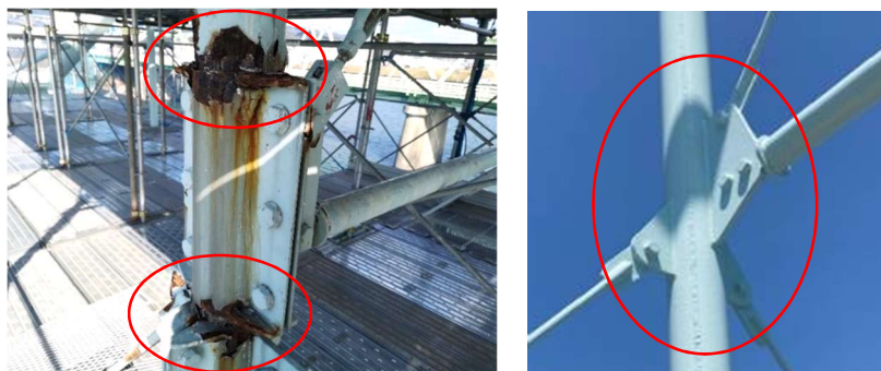
図-5 補強材接続部 (左：補強前 右：補強後)
