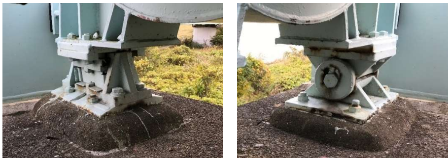
既設支承部 (左：ローラー支承 右：ピン支承)
