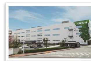
(静岡県) リコー環境事業開発センター
