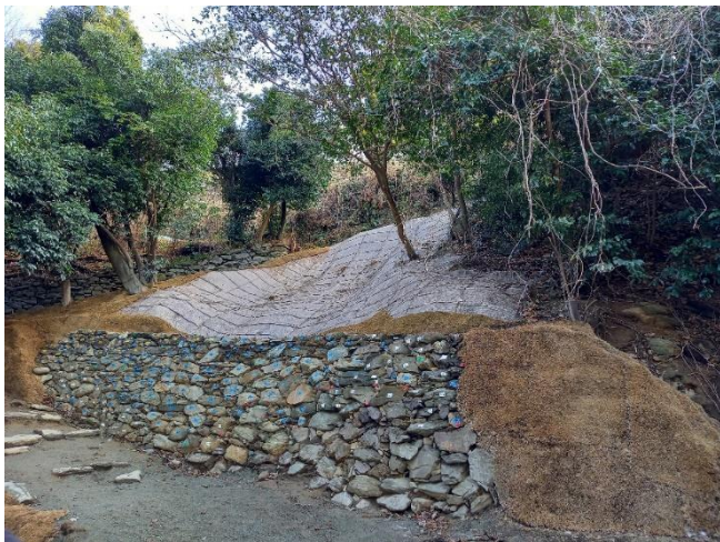
災害復旧直後の水の手郭の様子
