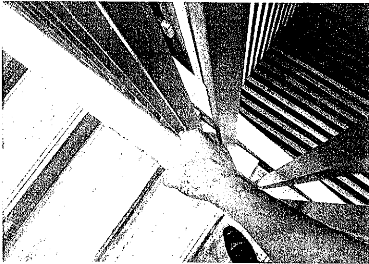
◀ 掴むと手の甲が怪我する 恐れのある手すり
