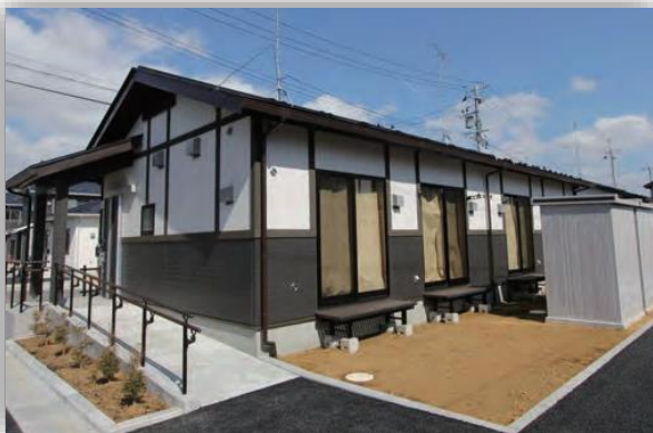
戸建タイプの災害公営住宅
