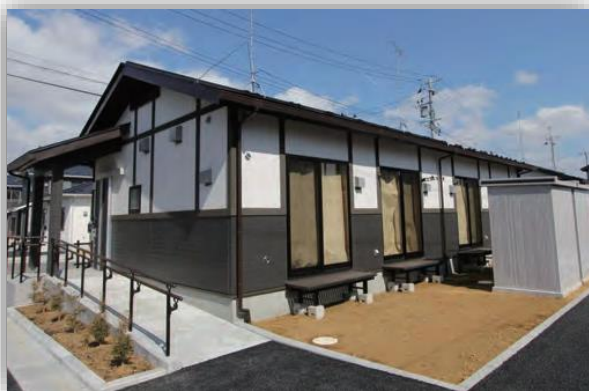
戸建タイプの災害公営住宅
