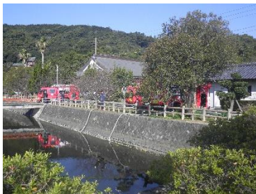
御手洗池を水源として放水
